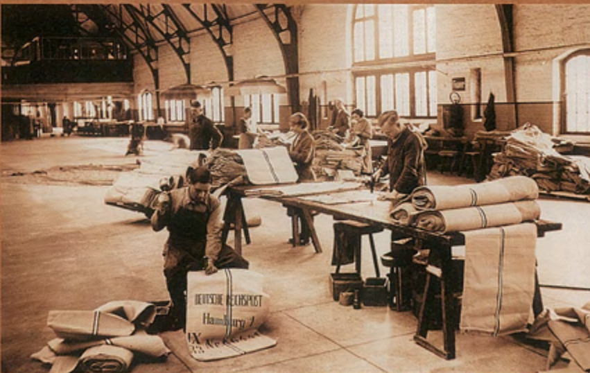
Saal 3. OG Hauptgebäude Sandershäuser Straße, 1934
