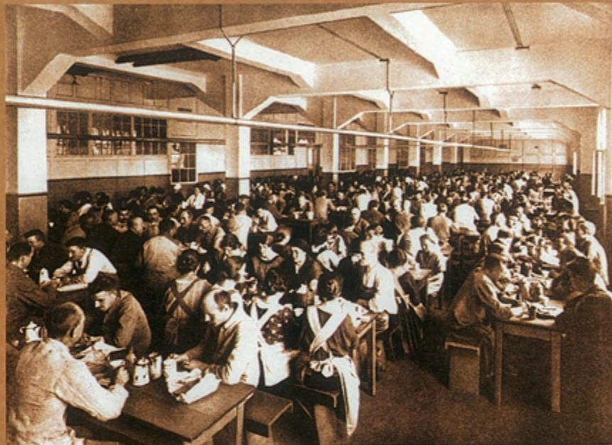
Arbeiter-Speisesaal Bettenhausen, Werk I, 1926
